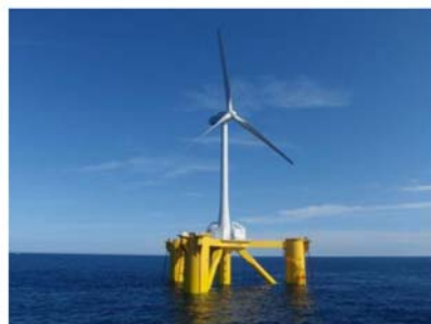
図1 福島沖 2MW 風車搭載セミサブ浮体
