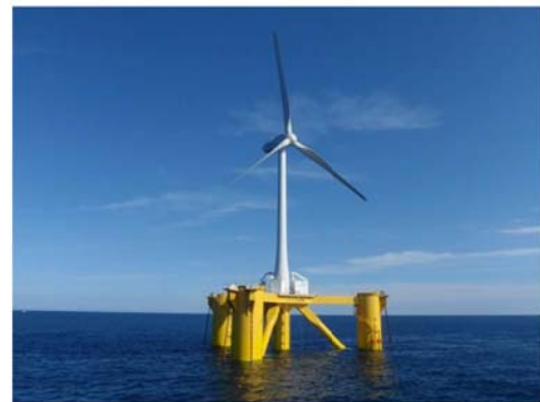
図 1 福島沖 2MW 風車搭載セミサブ浮体
