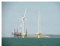
風車と観測タワーの概観
