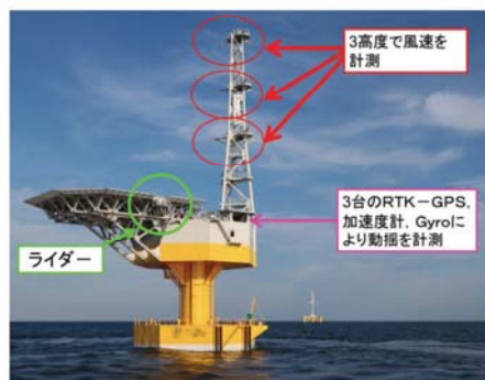
図4 福島県沖実証実験
