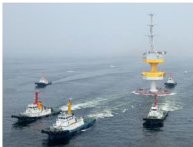
図12. サブステーションの曳航
