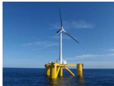
図 4. 2MW ダウンウィンド型風車搭載コンパクトセミサブ浮体
