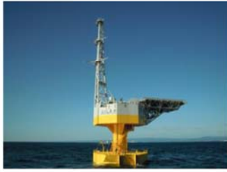
図 6. 浮体式サブステーション
