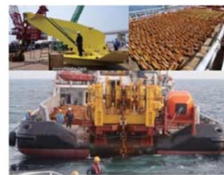
図 10. (a)アンカー (b)係留チェーン (c)チェーン敷設
