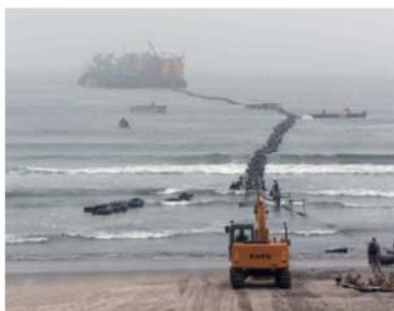
図13. 海底ケーブルの敷設
