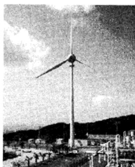
写真-1 風車の全体写真
