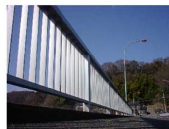
図12 実測対象橋梁の高欄
