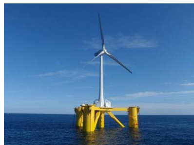
図1 福島沖2MW風車搭載セミサブ浮体
