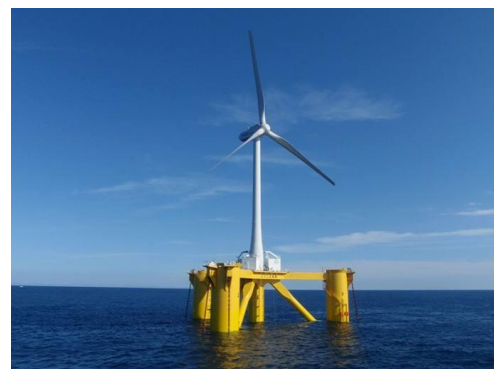
図1 福島沖2MW風車搭載セミサブ浮体
