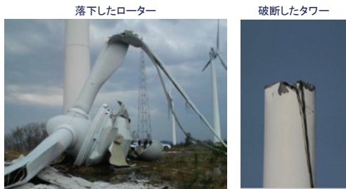
太鼓山風力発電所の風車事故の状況
