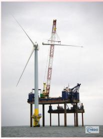
海上作業の安全性や定時性の確保、及び作業船種の選択による経済性の検討には、風車建設地点における海象・気象条件の高精度な推定と、想定される工法の施工稼働率の的確な予測が重要である。
