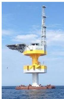
このとき浮体の動揺によるライダーの傾斜および水平移動が観測値に影響を与えることが問題となる<sup>[1]</sup>。そこで、本研究では、静的傾斜および水平移動速度に対する補正方法を提案するとともに、観測値との比較により提案手法の検証を行う。
