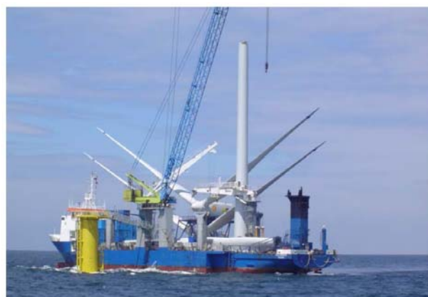
図 12 自己昇降型船による洋上風車の組立状況 14)
