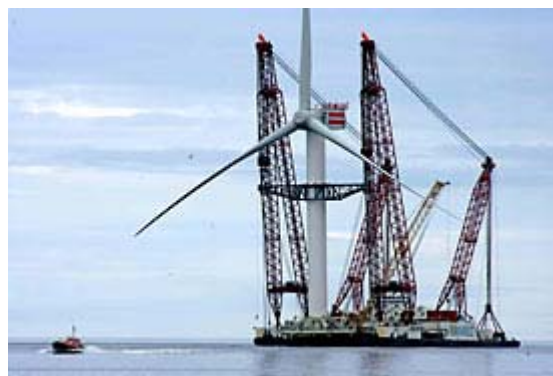
図 14 洋上風車の一体施工 16)
