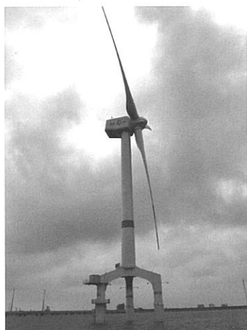
写真-4 BARD 5M風車とトリパイル支持構造物
