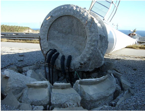
図-1 接合部コーン破壊の例 7)
