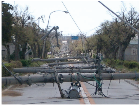
図-1 被災した配電用電柱
