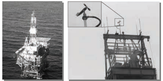
写真1 磐城沖ガス田プラットフォームと風向風速計
