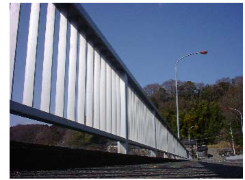
図 12 実測対象橋梁の高欄
