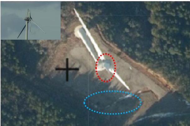
写真2 志賀町の風力発電設備のブレード損傷 15,2)
