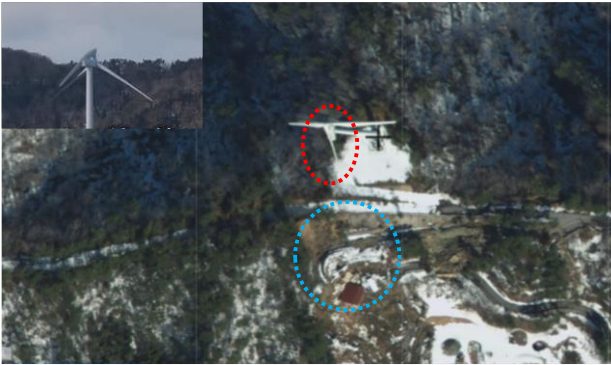
写真1 珠洲市の風力発電設備のブレード損傷 15,3)
