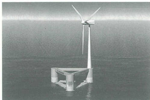
写真は三井海洋開発㈱、東洋建設㈱、古河電気工業㈱が共同で実施するNEDOの「次世代浮体式洋上風力発電システム実証研究パス図
