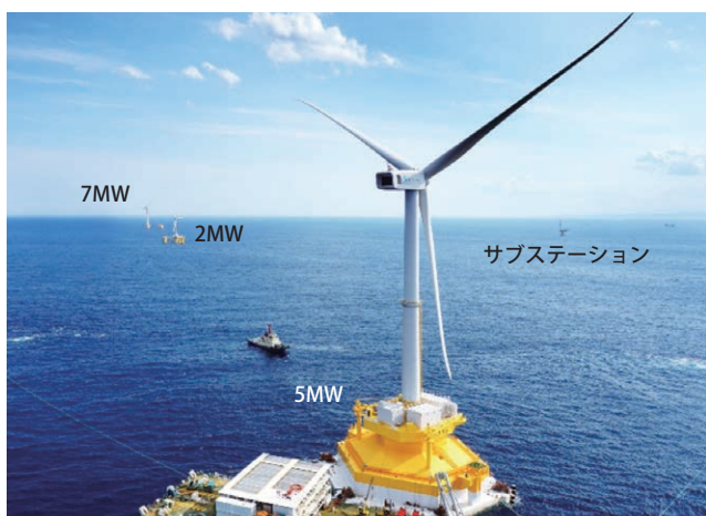
図5 福島沖世界初の浮体式洋上ウィンドファーム (7)
