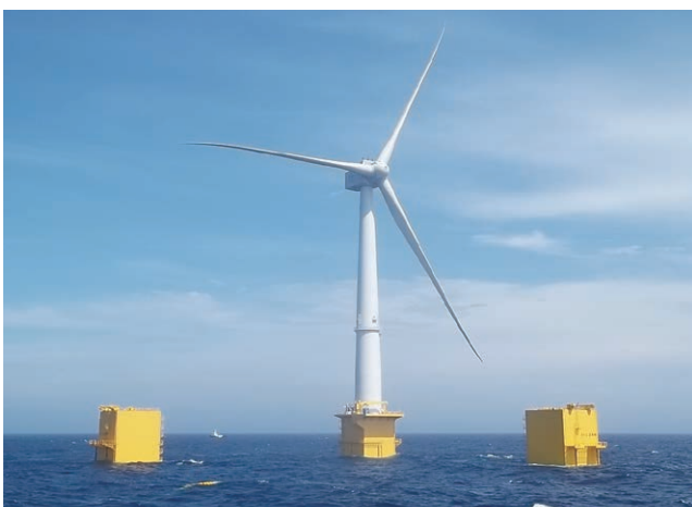
図3 世界最大級の7000kW洋上風車 (7)
