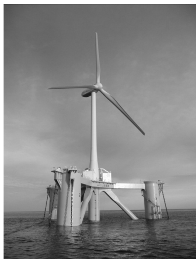
図 6 完成した 2MW 浮体式洋上風車
