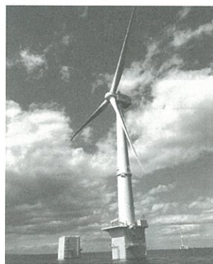
楡葉沖約30km地点にある浮体式洋上ウィンドファーム
