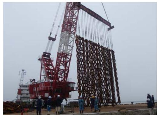
図7 敷設船への係留チェーン積込状況
