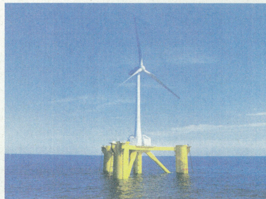
福島県沖20キロの洋上に浮かぶ、2000キロワットの風力発電設備「ふくしま未来」
