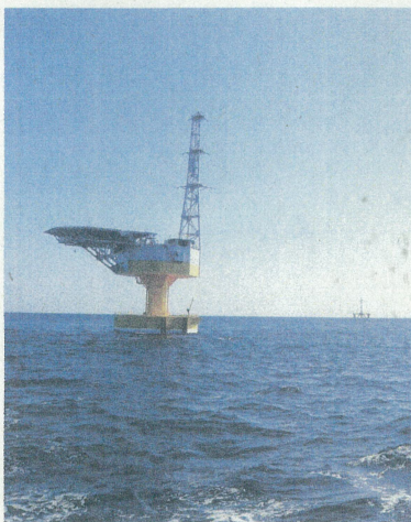
浮体式洋上サステーション「ふくしま絆」。右側のはるか遠くに見えるのが「ふくしま未来」
