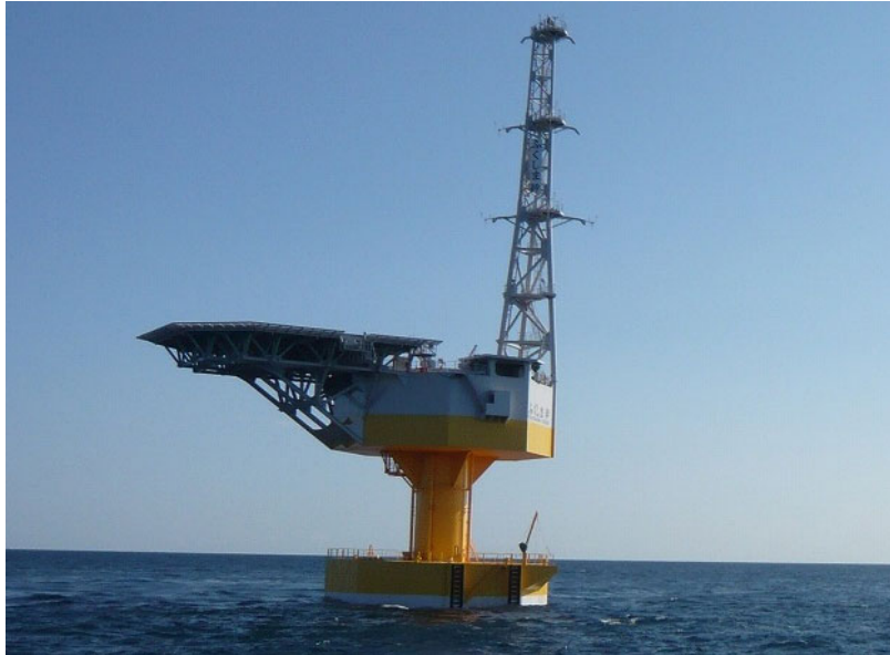
図 2 浮体式洋上変電設備の「ふくしま絆」(出典:福島洋上風力コンソーシアム)
