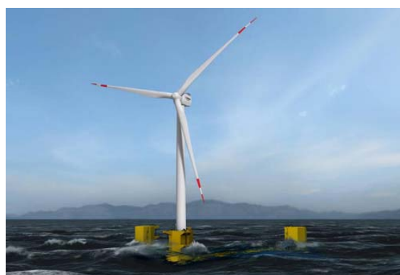
図9 7000kW浮体式洋上風力発電設備の完成予想図
