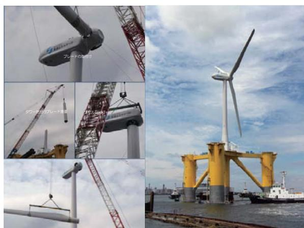
図3 完成した2MW浮体式洋上風車
