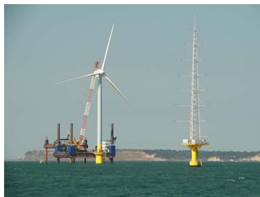
図5 銚子沖に建設された観測タワーと洋上風車 4)
