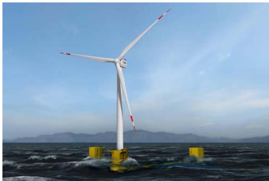
図6 7000kW 浮体式洋上風力発電設備の完成予想図 (5)
