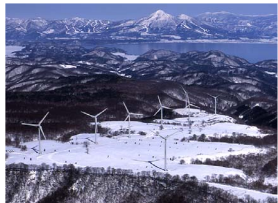
図 2 郡山布引高原風力発電所 (電源開発提供)
