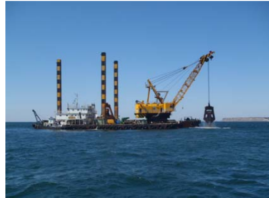
図 23 海底地盤の掘削
