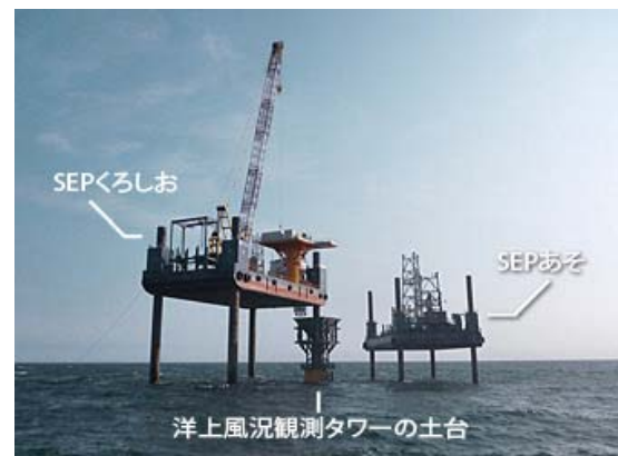
図 24 SEP による洋上観測タワーの建設状況
