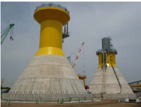
図 22 洋上風車 (左) と観測タワー基礎 (右) の製作
