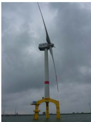
図-5 BARD 5M 風車とトリパイル支持構造物
