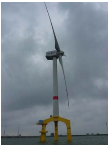
図8 BARD 5M 風車とトリパイル支持構造物
