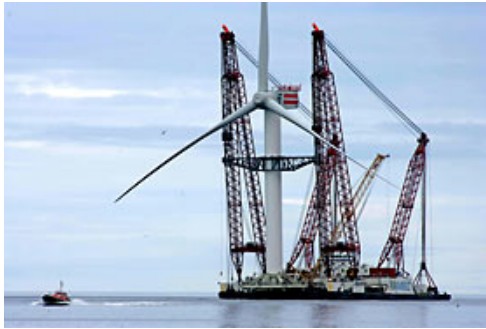
図7 洋上風車の一体施工 8)
