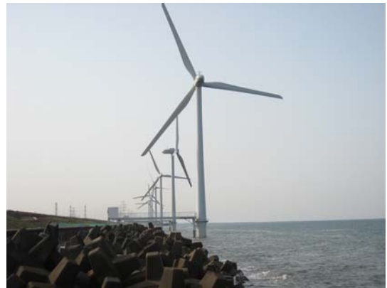
図5 神栖洋上風力発電所
