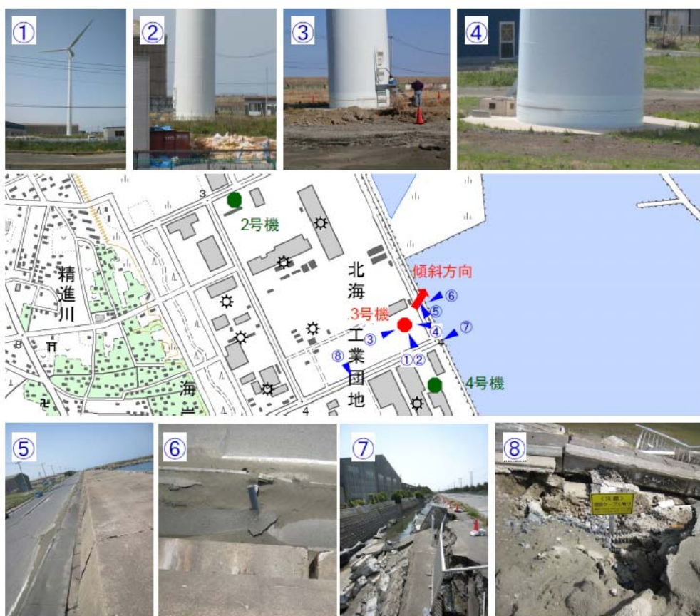
図6 鹿嶋発電所3号機とその周辺の被害状況
