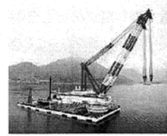
起重機船 (基礎輸送・据付用)
