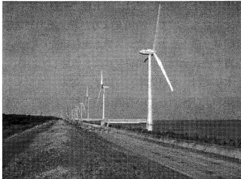
図3 神栖洋上風力発電所 3)
