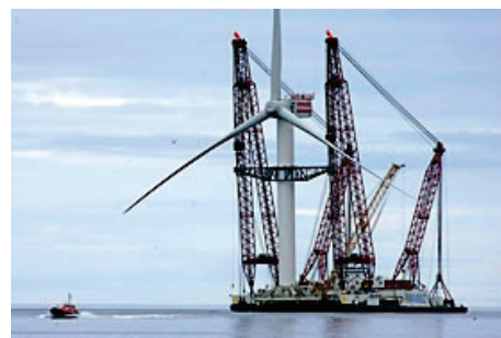
図21 洋上風車の一体施工 16)
