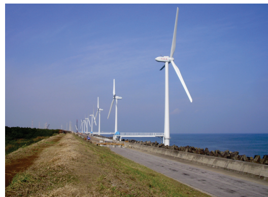
図7 神栖洋上風力発電所 10)
