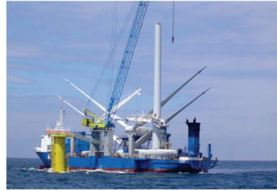
図19 自己昇降型船による洋上風車の組立状況 14)
