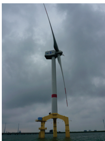
図22 BARD 5.0 風車とトリパイル支持構造物 2)
