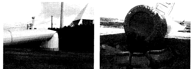
(a) タワーの倒壊 (b) 基礎の破壊 図-1 風力発電設備支持物の台風被害の一例
