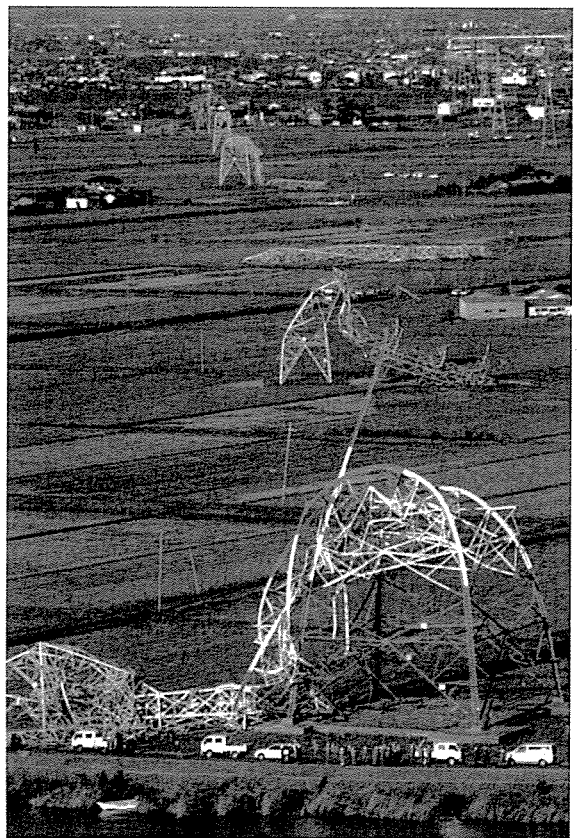
写真-1 台風21号の強風で倒壊した送電鉄塔
