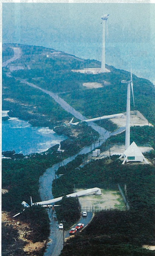
図-1 台風14号の強風で倒壊した風車(提供:朝日新聞社)
