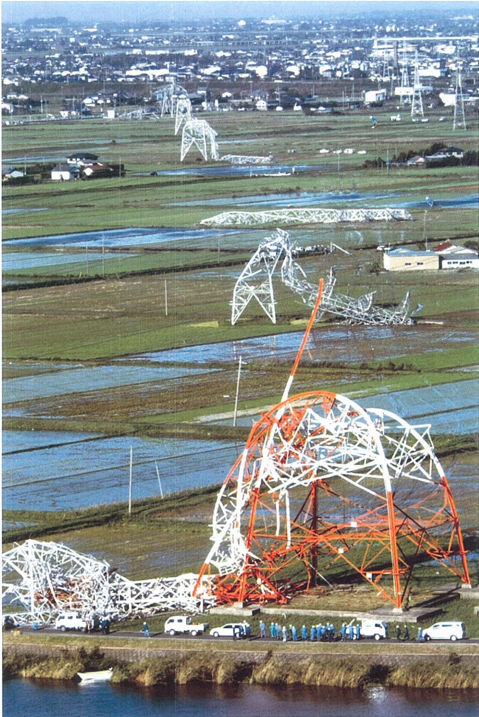
Fig. 1 台風21号の強風で倒壊した送電鉄塔
