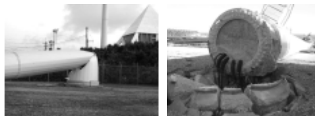
(a) タワーの倒壊 (b) 基礎の破壊
