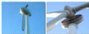
ブレードの折損
