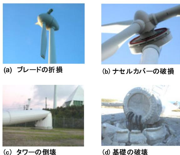
図-1 風力発電設備の台風被害
