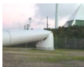
(1) タワーの倒壊
